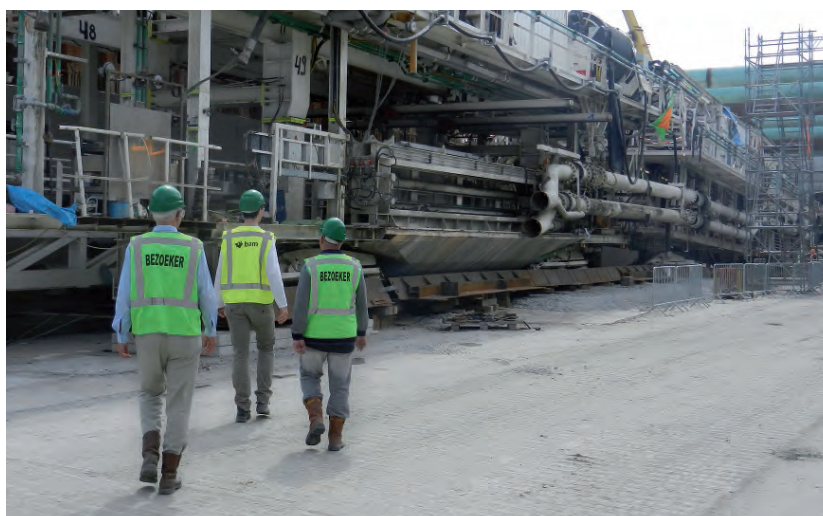
De tunnelboormachine voor de Sluiskiltunnel is speciaal gebouwd voor het project. Het snijrad heeft een doorsnede van elf meter en is aangepast aan de Zeeuws-Vlaamse bodem. Per dag wordt zo'n tien meter tunnel aangelegd. (Foto: Harry Bijl)
