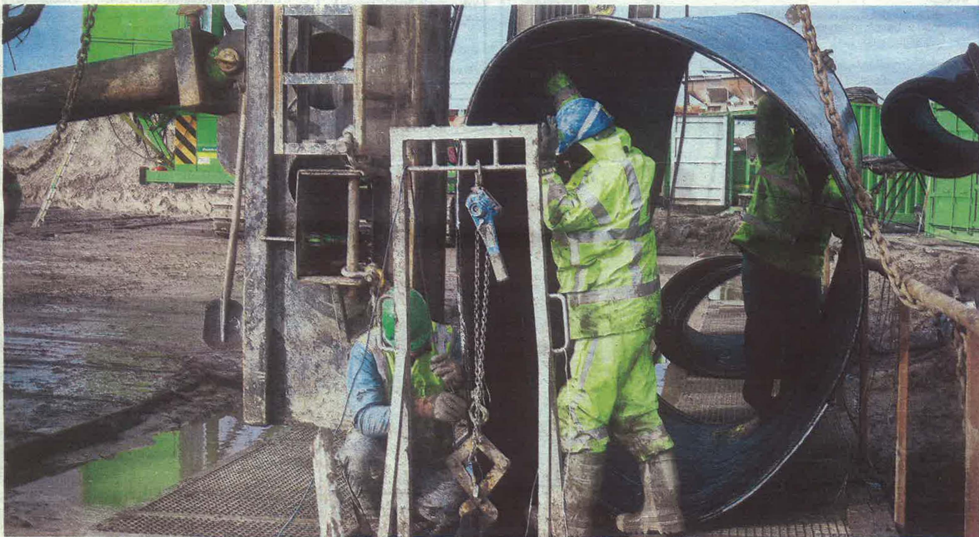
Bij het werk aan de Haak wordt voor de onderdoorgangen onder het spoor naar Stavoren/Harlingen in plaats van stalen damwanden kunststoffolie gebruikt om water weg te houden. FOTO: LC/SIEP VAN LINGEN
