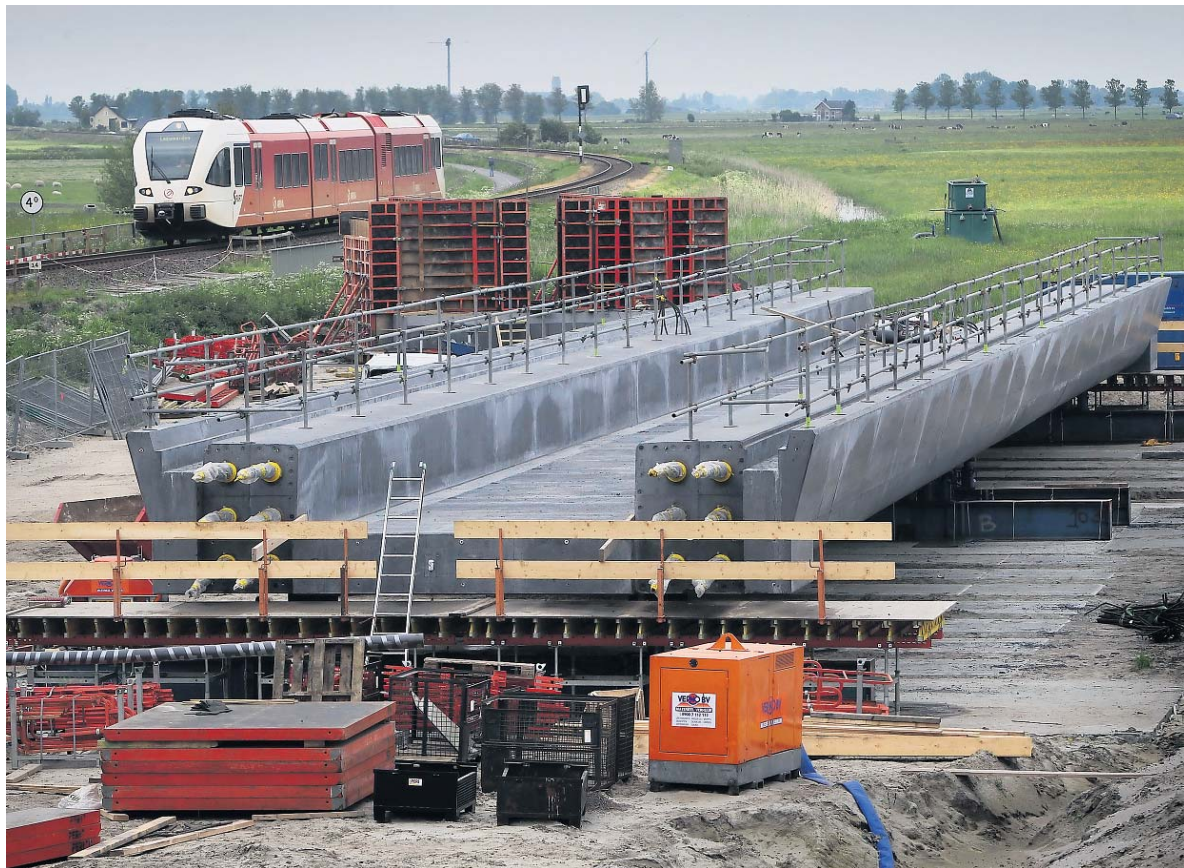
Langs het spoor van Leeuwarden naar Stavoren wacht een 60 meter lang spoorviaduct om te worden ingeschoven. Hier loopt straks de Haak om Leeuwarden. FOTO: IC/NIJES WESTRA
