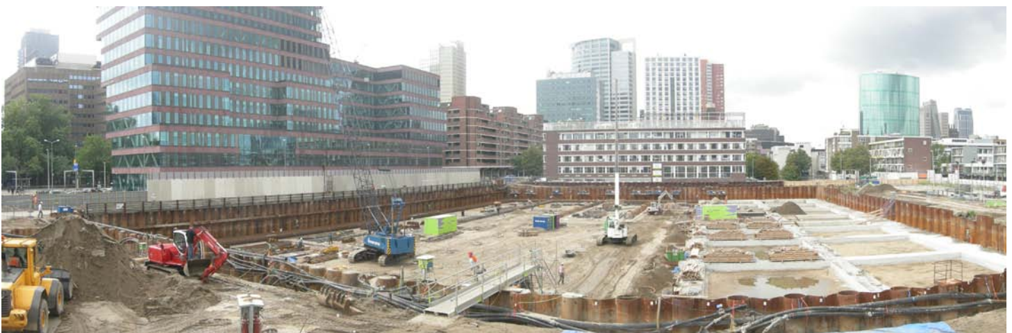
De bouwput anno vandaag
